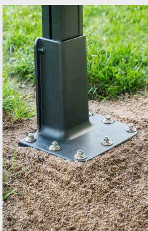
Fästplatta på gjuten plint.
